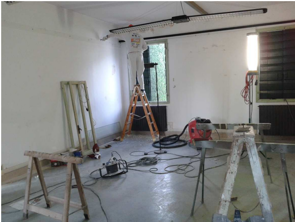
fase finale dei lavori di dipintura
