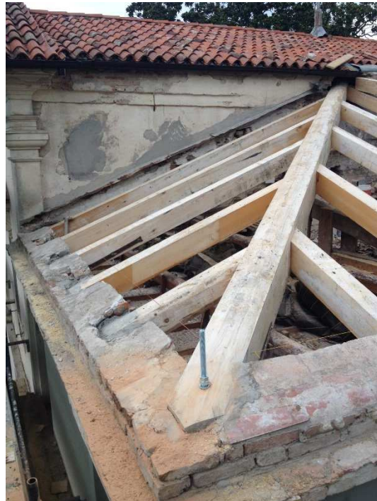
consolidamento strutturale cornice: ancoraggi delle travi in legno alle murature perimetrali
