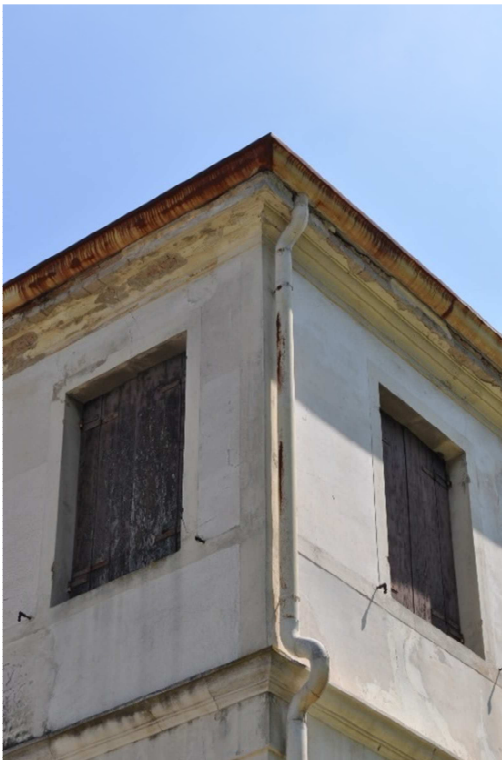
stato prima dei lavori
