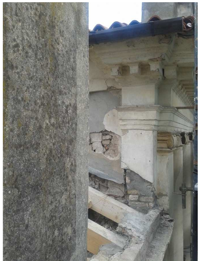
sostituzione travi portanti e orditura secondaria in legno
