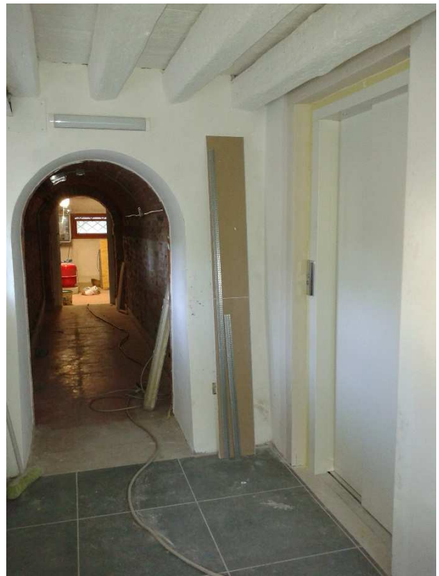
installazione dell'impianto ascensore
