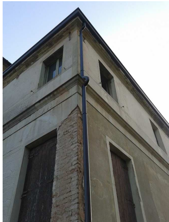
sostituzione pluviali, canali di gronda e lattronerie
