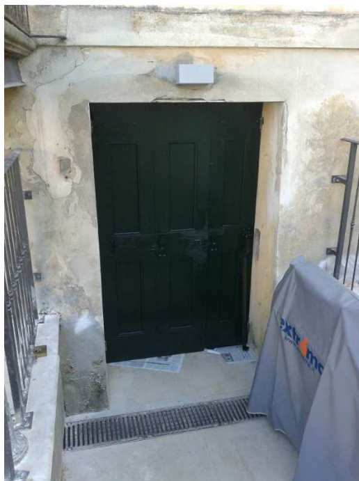
ripristino del portone d'ingresso piano seminterrato
