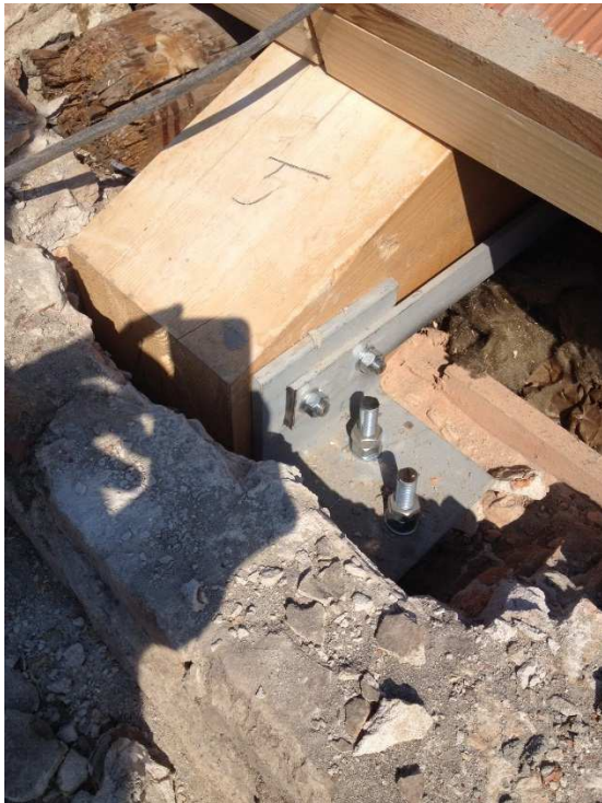
consolidamento strutturale cornice: ancoraggi delle travi in legno alle murature perimetrali
