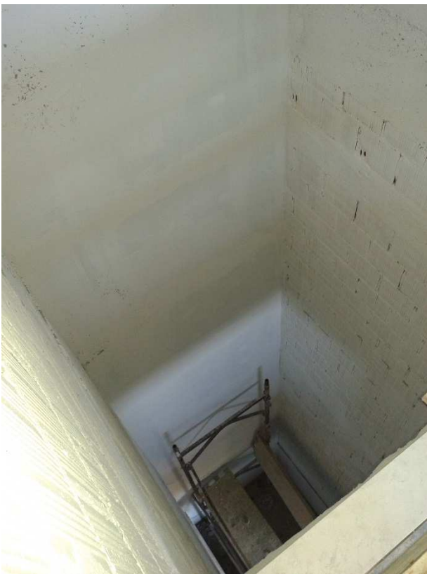
il vano ascensore
