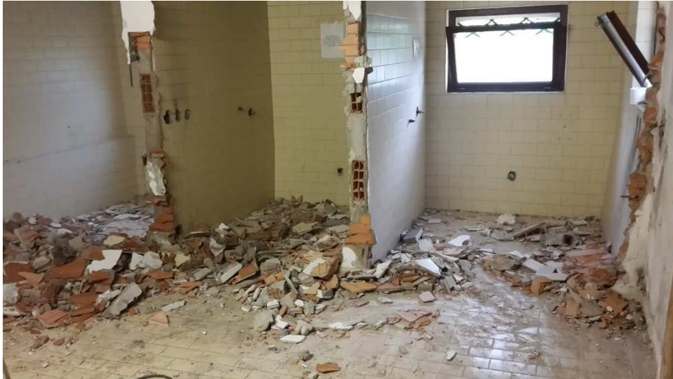
demolizione pareti in laterizio esistenti
