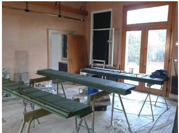
smontaggio, carteggiatura, reintegro parti lignee mancanti, stuccature, stesura olio di lino, verniciatura finale e rimontaggio
