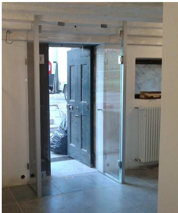
la nuova bussola d'ingresso in cristallo antifondamento
