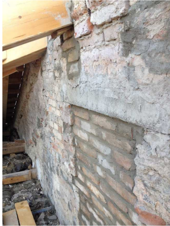
scuci-cuci dei muri del sottotetto del corpo centrale
