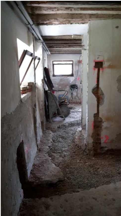
demolizione dei pavimenti per le nuove tubazioni
