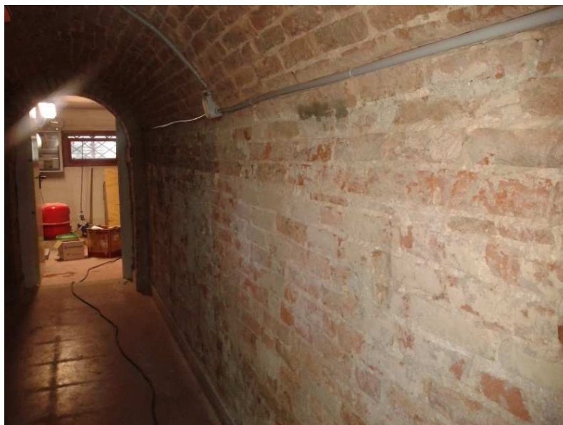
rimozione intonaci ammalorati e sabbatura della muratura
