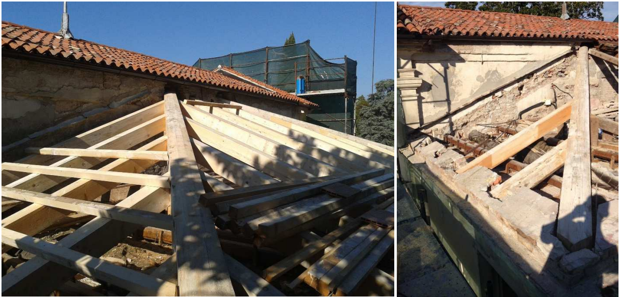
rifacimento parziale travi lati nord e sud
