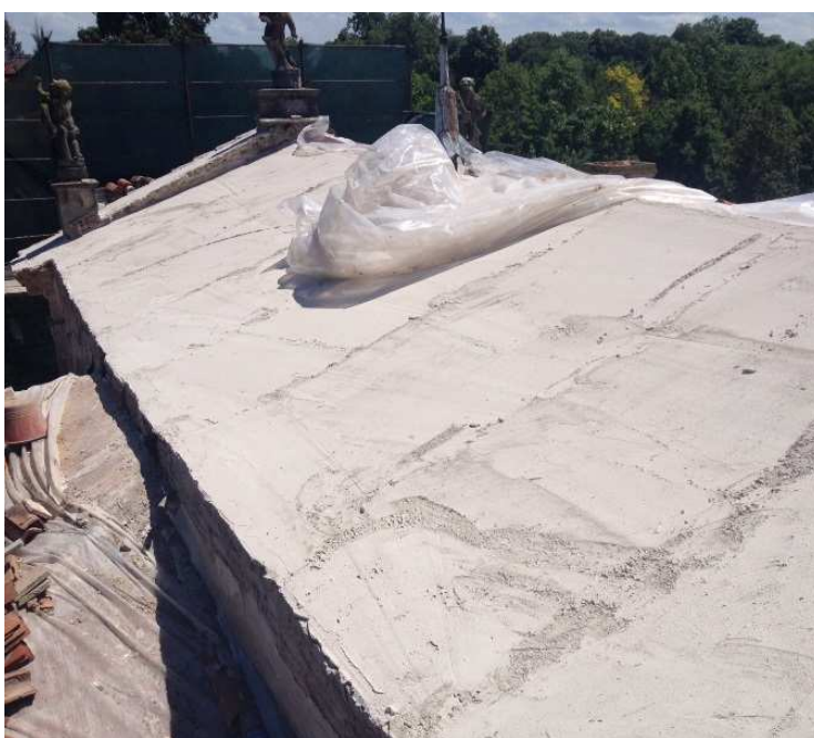
rasatura in biocalce
