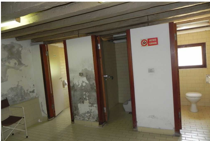
i locali prima dei lavori
