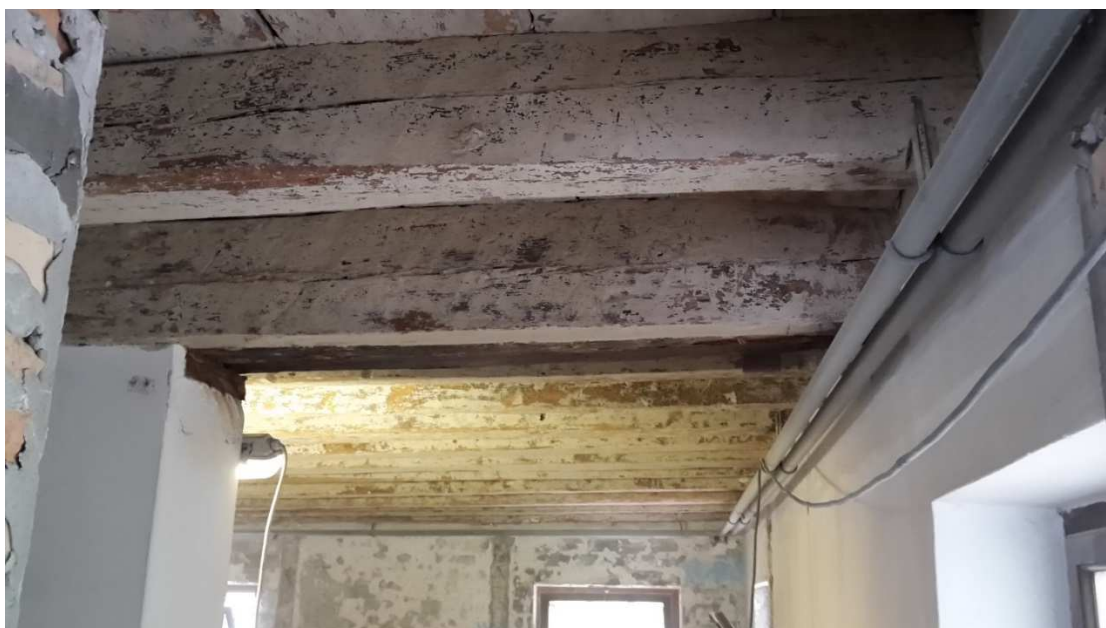
le travi in legno del piano seminterrato prima dei lavori
