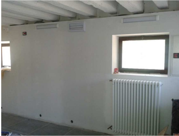
contropareti in cartongesso (gessofibra) per miglioramento condizioni igrotermiche e ignifugo
