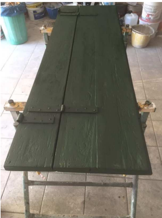
smontaggio, carteggiatura, reintegro parti lignee mancanti, stuccature, stesura olio di lino, verniciatura finale e rimontaggio
