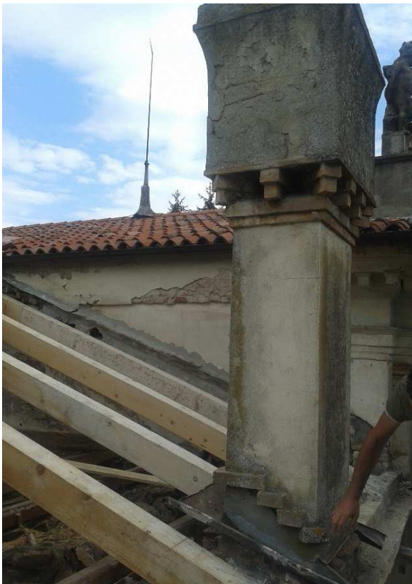
sostituzione travi portanti e orditura secondaria in legno
