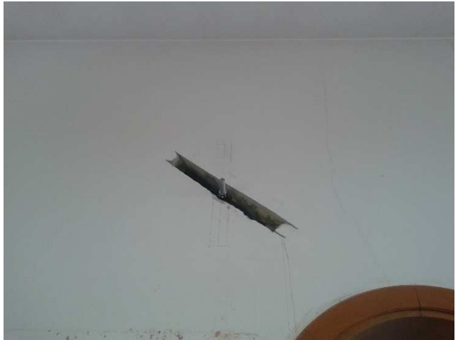
inserimento tiranti in acciaio lungo i muri perimetrali del piano primo e capochiave incassati nella muratura
