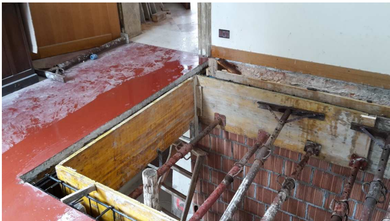
Il taglio del solaio in legno e nuove murature portanti
