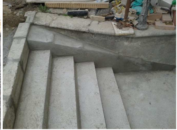
nuova scala in cemento armato
