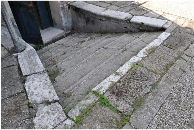
la rampa prima dei lavori
