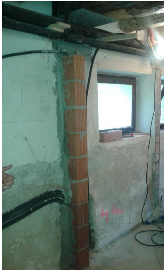
piastra in acciaio di sostegno della trave del pianerottolo della scala al piano seminterrato
