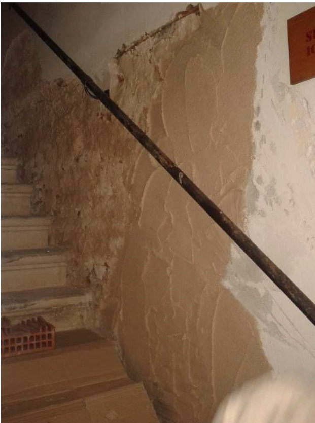
rimozione intonaci ammalorati e trattamenti deumidificanti
