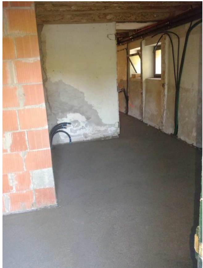
massetto di pavimento e impermeabilizzazione
