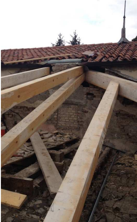
particolare dei tiranti
