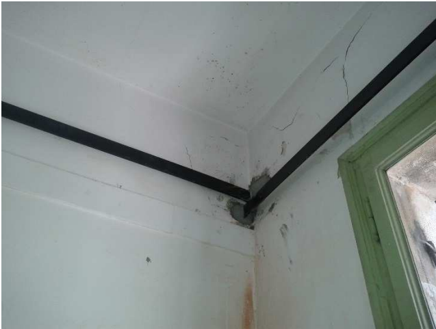
inserimento tiranti in acciaio lungo i muri perimetrali del piano primo e capochiave incassati nella muratura
