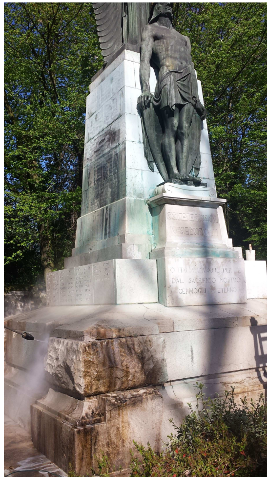
Risciaqui con idropulitrice
