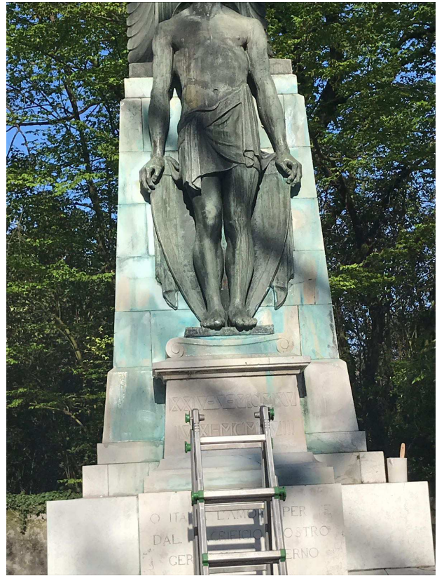
Risultato dopo il terzo impatto e lavaggio
