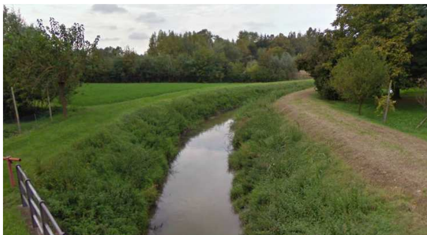
Scolo Lusore in corrispondenza a Via Barbato (Campocroce)
