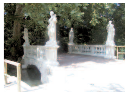
Castelletto di Villa Erizzo - Belvedere: veduta del ponte restaurato
