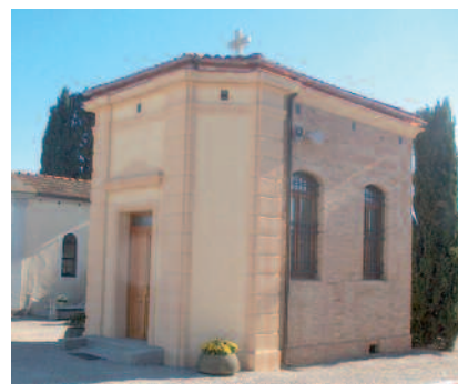
Cimitero di Campocroce: chiesetta restaurata
