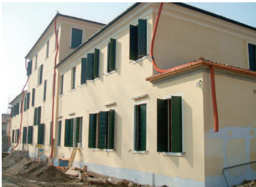
Ex Municipio di via Bastia Fuori: nuova sede uffici comunali
