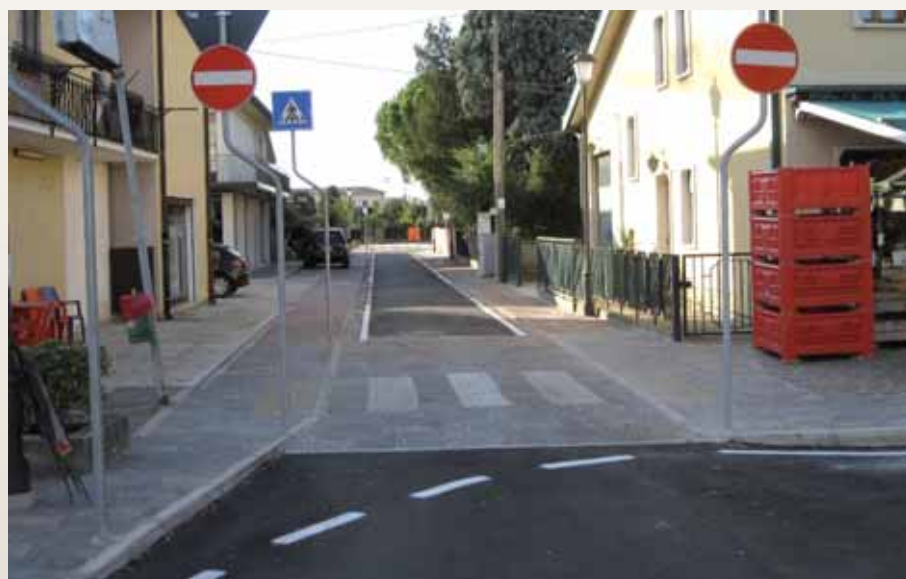
Intervento nel centro di Scaltenigo
