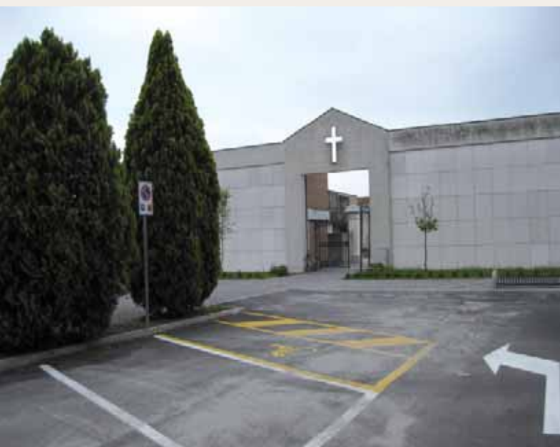
Parcheggio del Cimitero di Ballò e impianto di sollevamento a Campocroce
