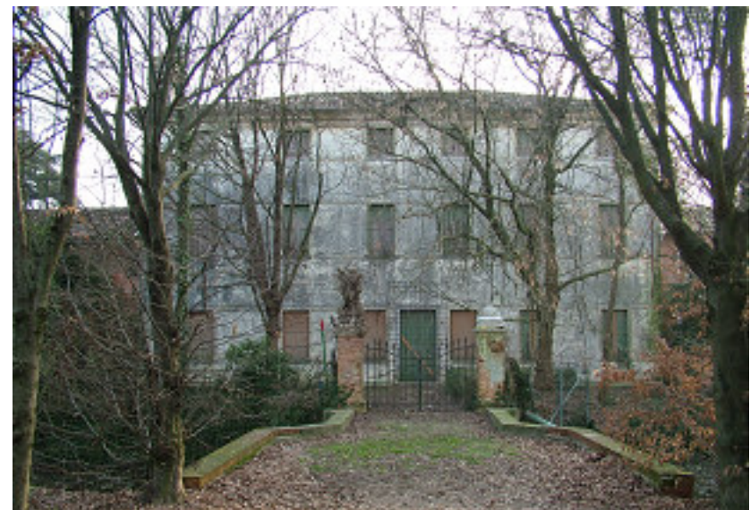
Fig. 15 Ingresso alla villa lato nord
